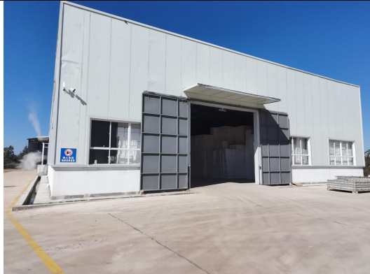
生产车间现状
