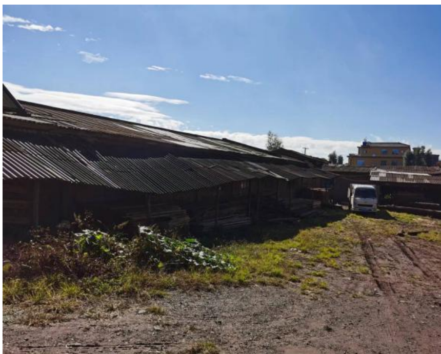
项目西侧闲置房屋
