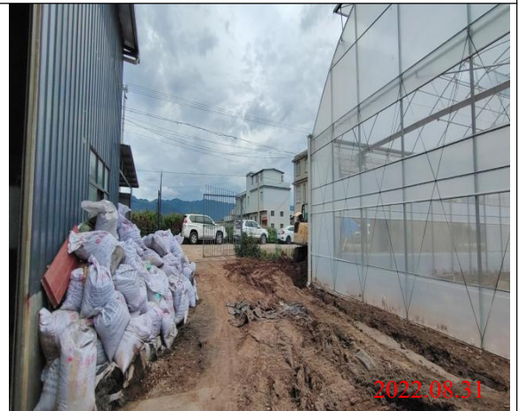
蒸汽发生器生物质燃烧后炉渣现状堆存点
