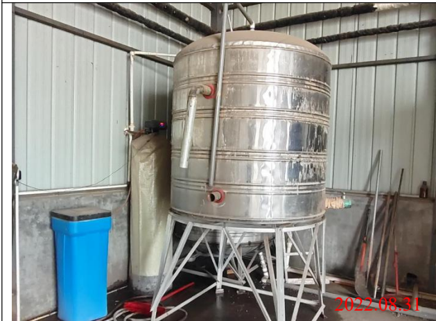
蒸汽发生器配套软水处理系统
