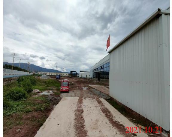
锅炉房建设点
