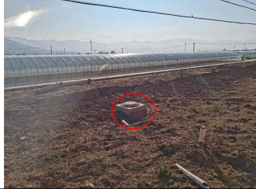
拟建项目区西侧及园区污水管网接口
