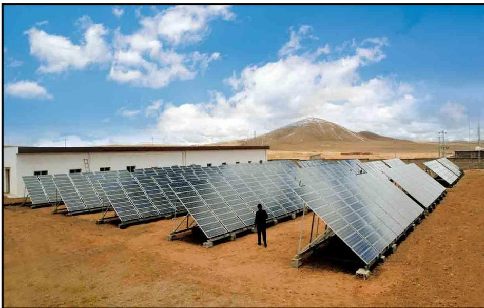
图 2-2 固定式安装运行方式
